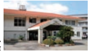
特別養護老人ホーム 「樋谷荘」開設
