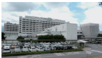
愛媛大学医学部附属病院(644床 愛媛県東温市)
