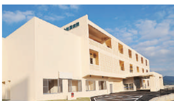
北部地区医師会病院(236床 沖縄県名護市)
